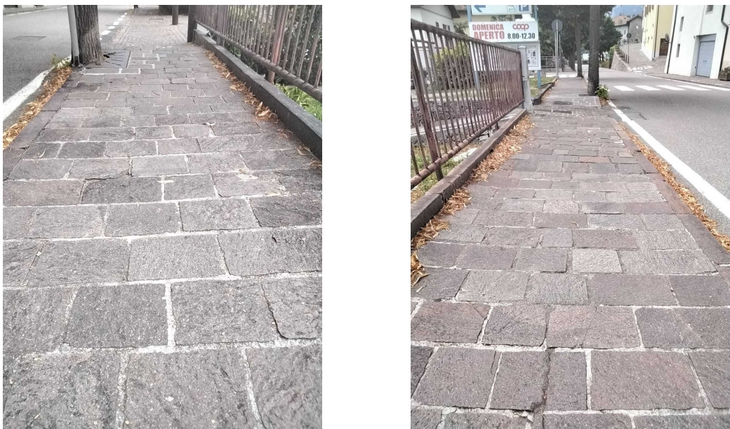
Foto dell'elemento Foto d'inquadramento
