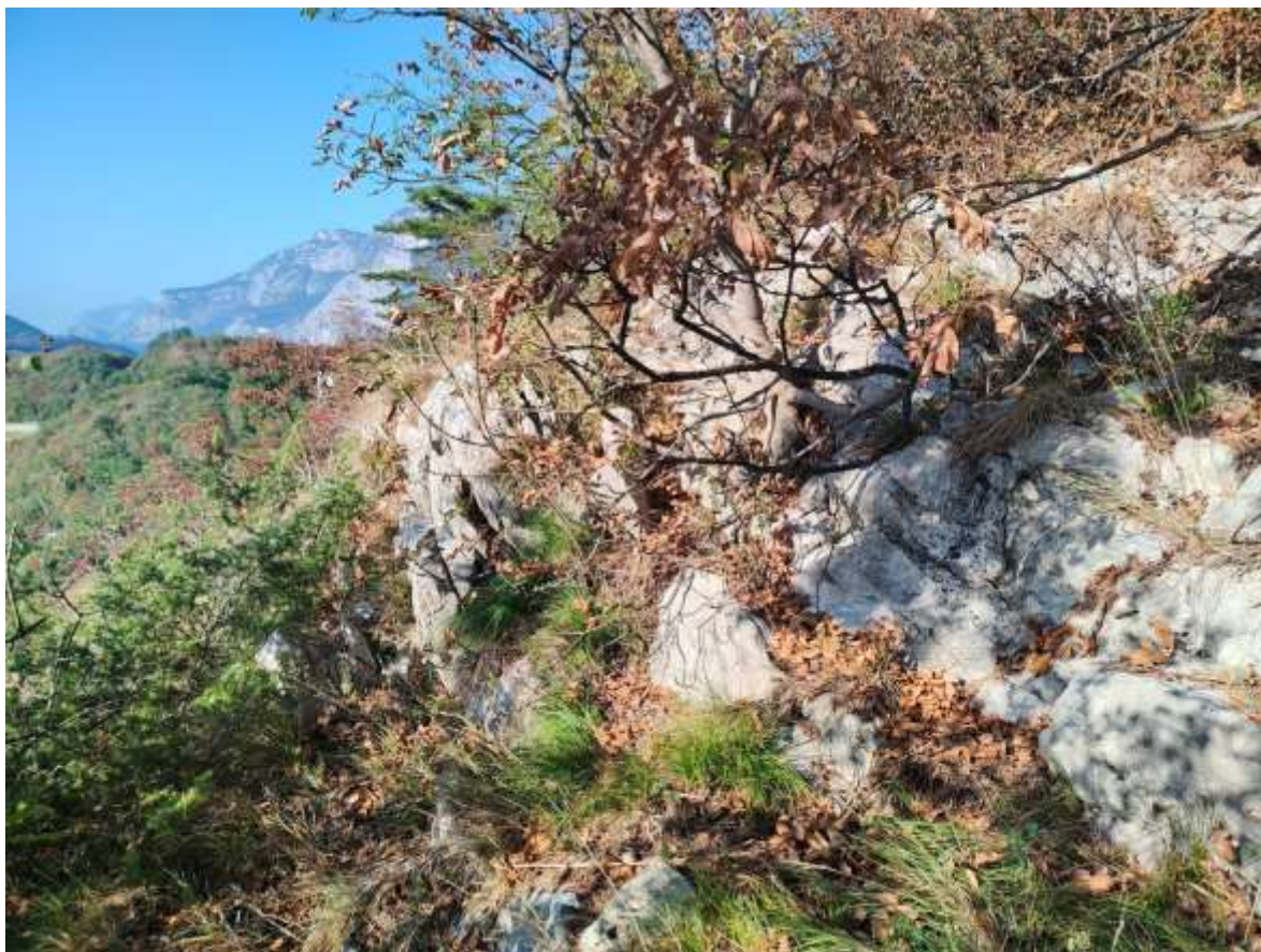
Figura 7.17 Affioramenti alla testa del parete
