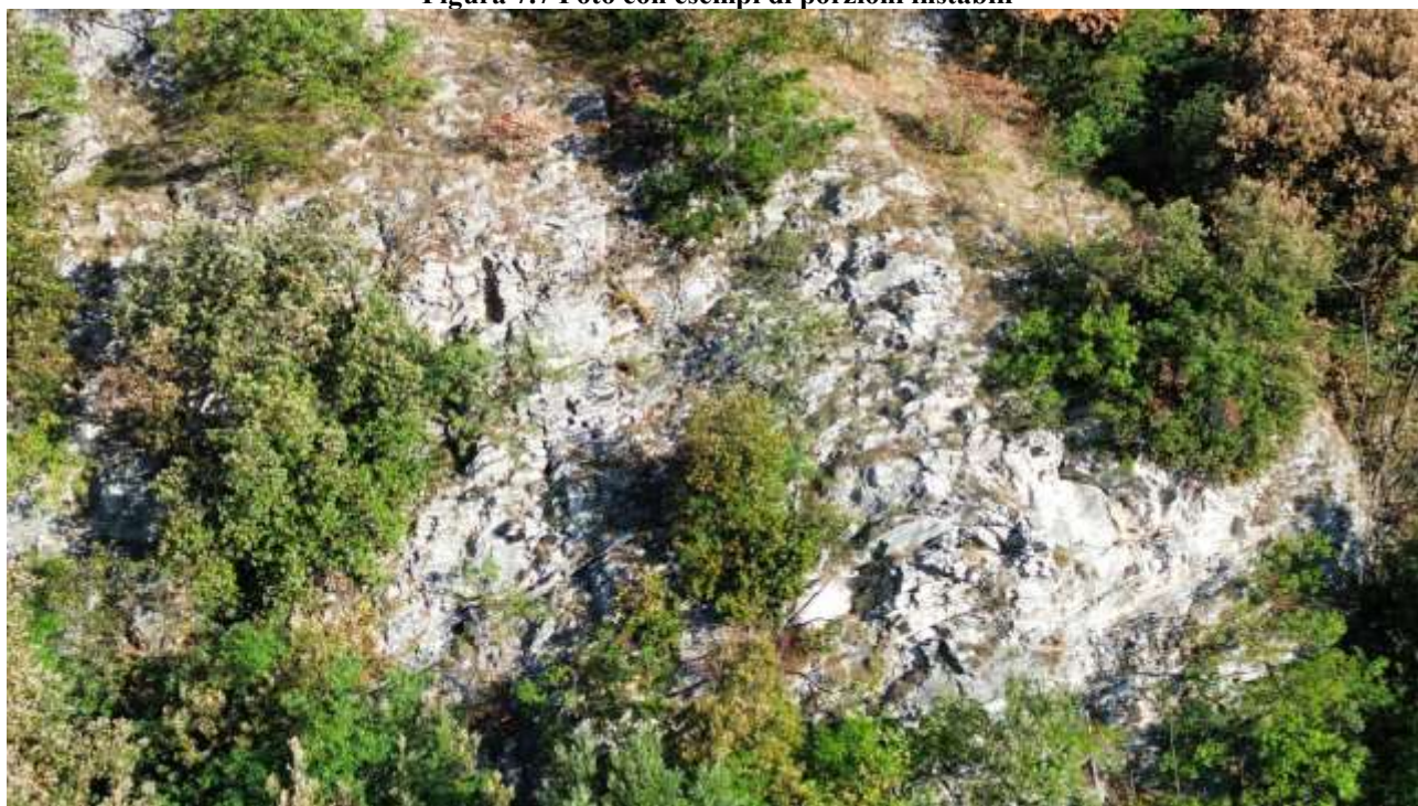
Figura 7.8 Foto con esempi di porzioni instabili
