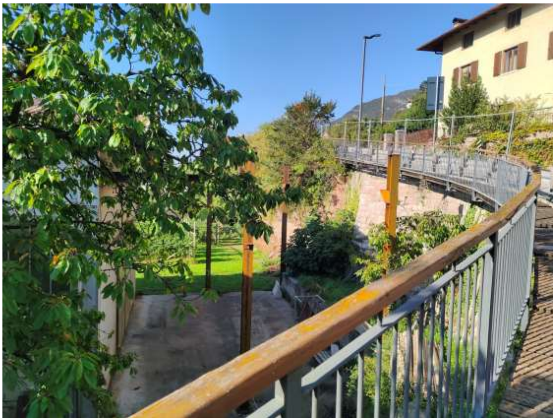
Figura 7.19 Dettaglio del muro – parete subito a monte del sito
