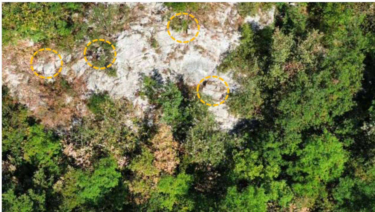
Figura 7.7 Foto con esempi di porzioni instabili
