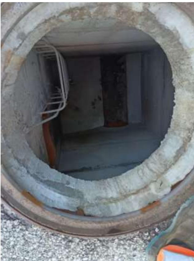
Figura 5.1 Immagini di dettaglio del pozzetto che origina la pericolosità APPr Da notare l'arrivo di una tubazione singola.
