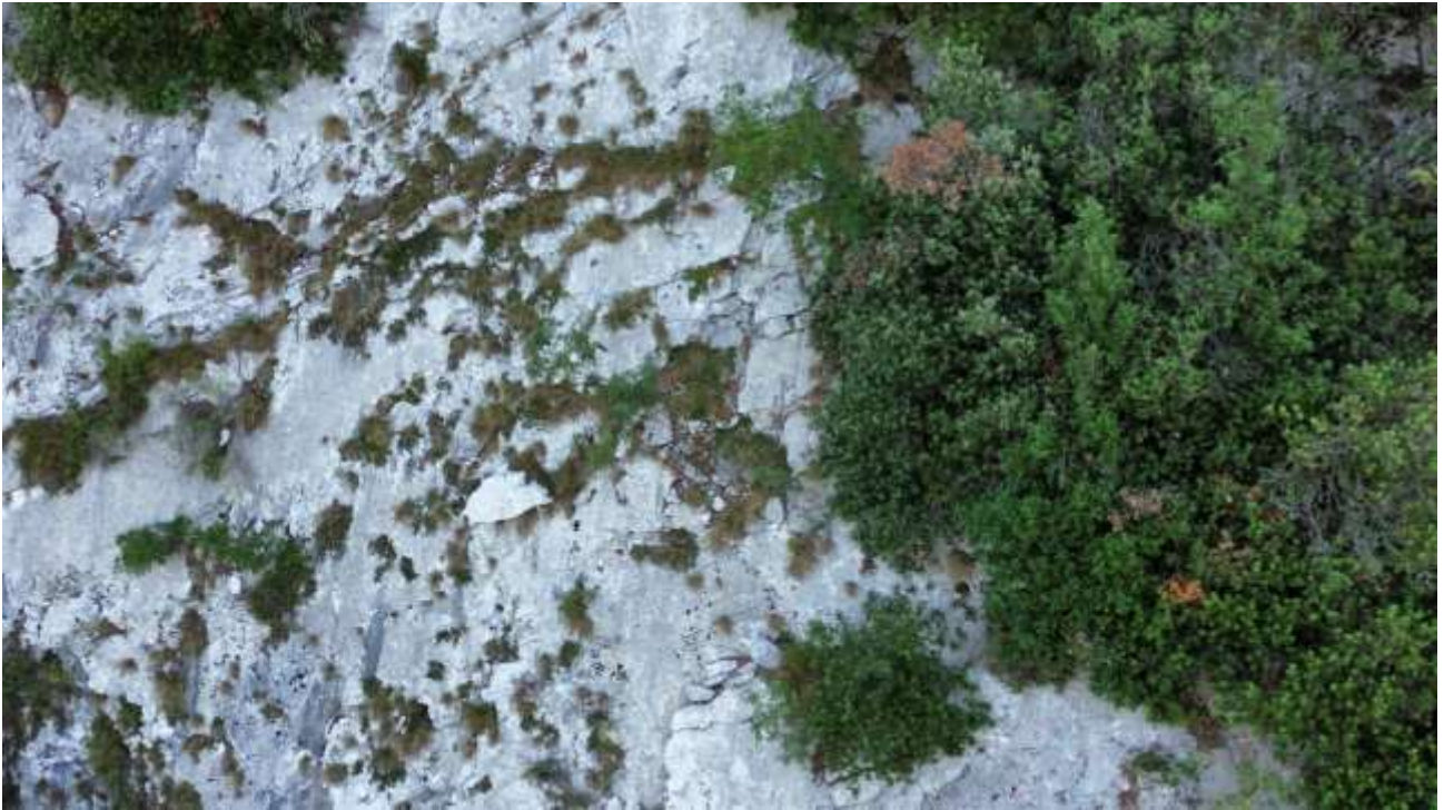
Figura 7.7 Foto con esempi di porzioni instabili
