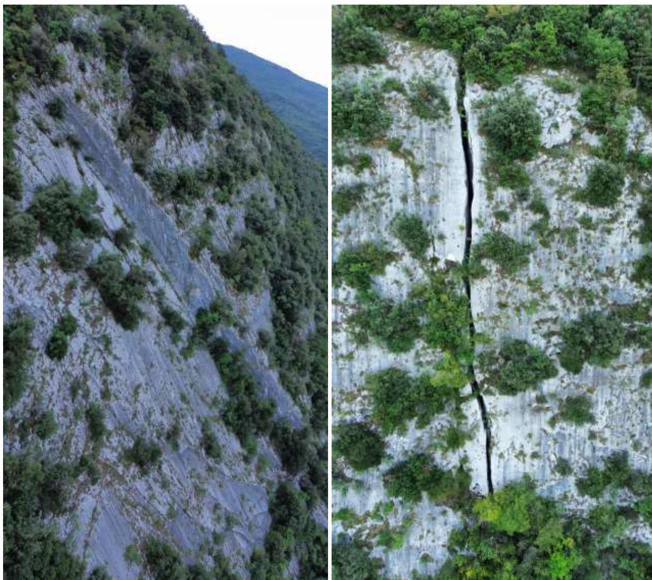
Figura 7.9 Importante diedro e fessura
