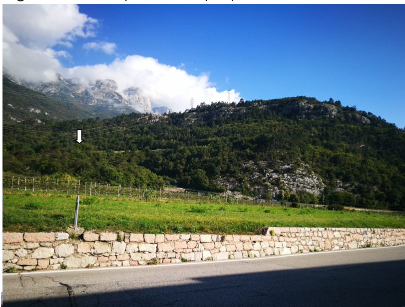
Foto n. 1 - Vista dal fondo valle, nei pressi area artigianale di Terlagio
