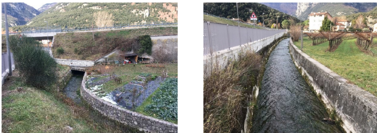
Figura 5.6 Tratto di valle della roggia di Padergnone. A sinistra lo scatolare sottostante la SS45Bis, mentre a destra l'ultimo tratto prima dell'immissione nel lago di Santa Massenza
