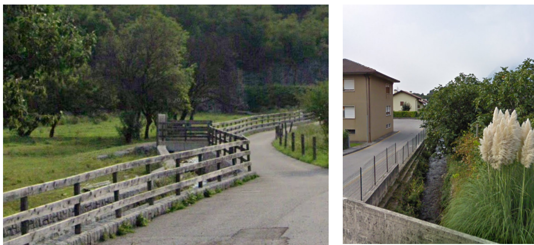
Figura 5.2 Roggia di Padergnone lunga la SS45Bis a monte di Vezzano a sinistra e roggia di Padergnone nel paese di Vezzano a destra
