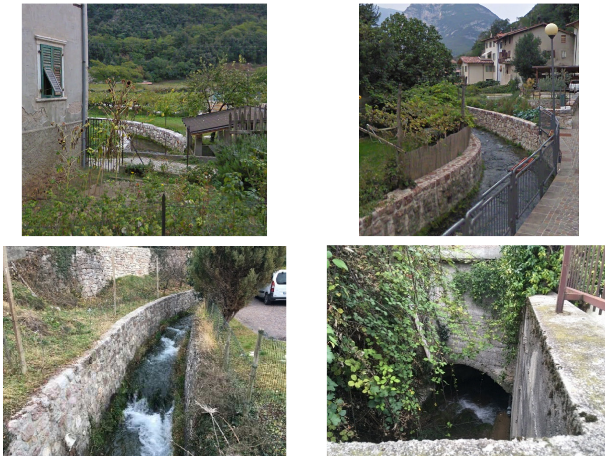
Figura 5.5 Tratti tombati e a cielo aperto del canale Rimone lungo il paese di Padergnone
