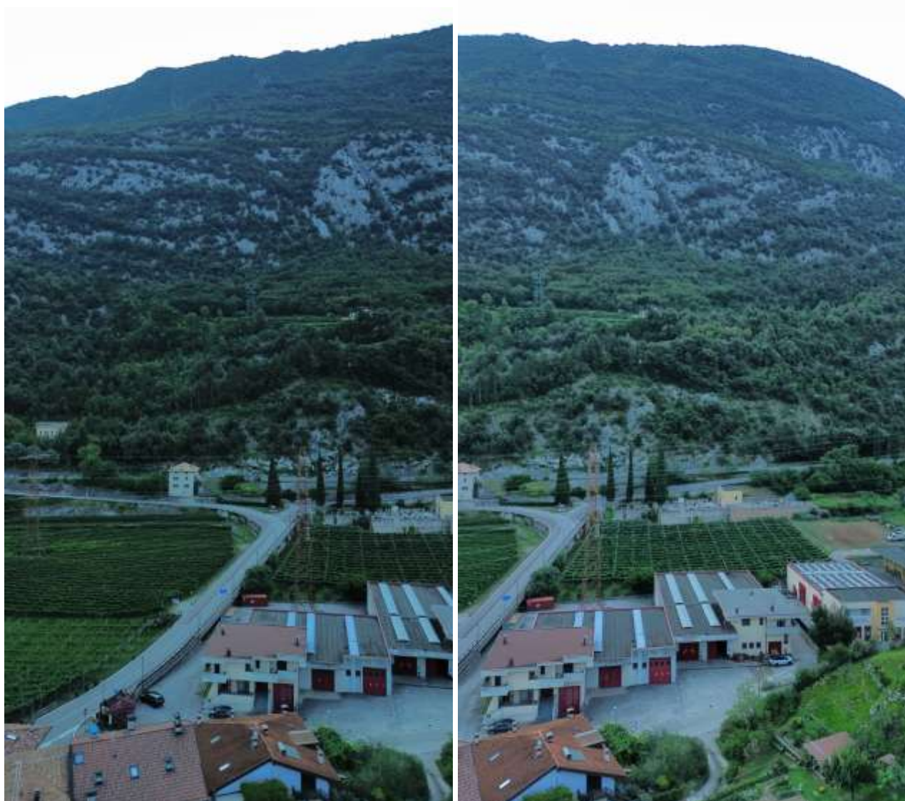
Figura 7.3: Vista da Ovest
