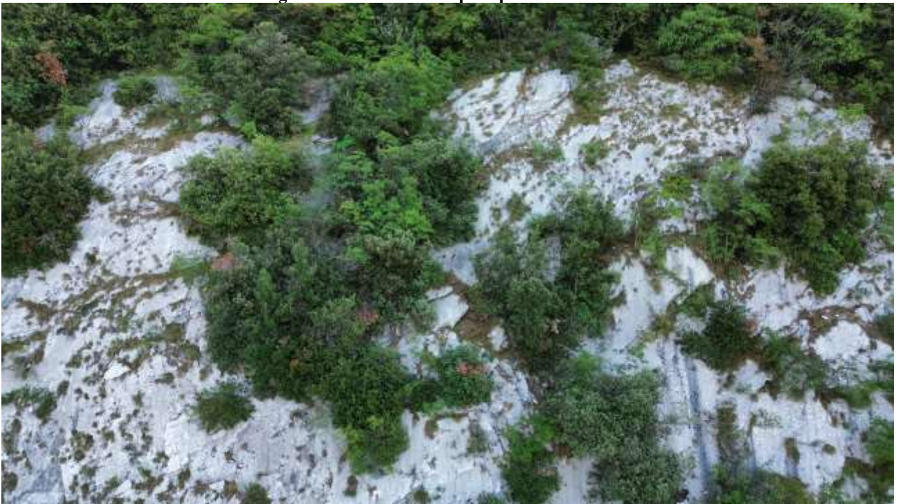
Figura 7.8 Foto con esempi di porzioni instabili
