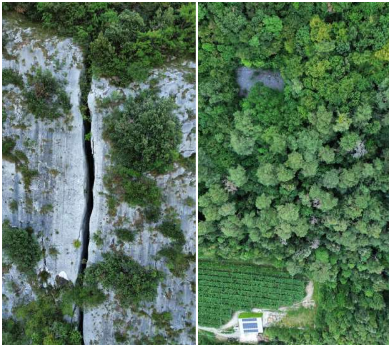
Figura 7.13 Foto con esempi di crolli recenti e dettaglio su una parte di falda non vegetata (alta attività?)
