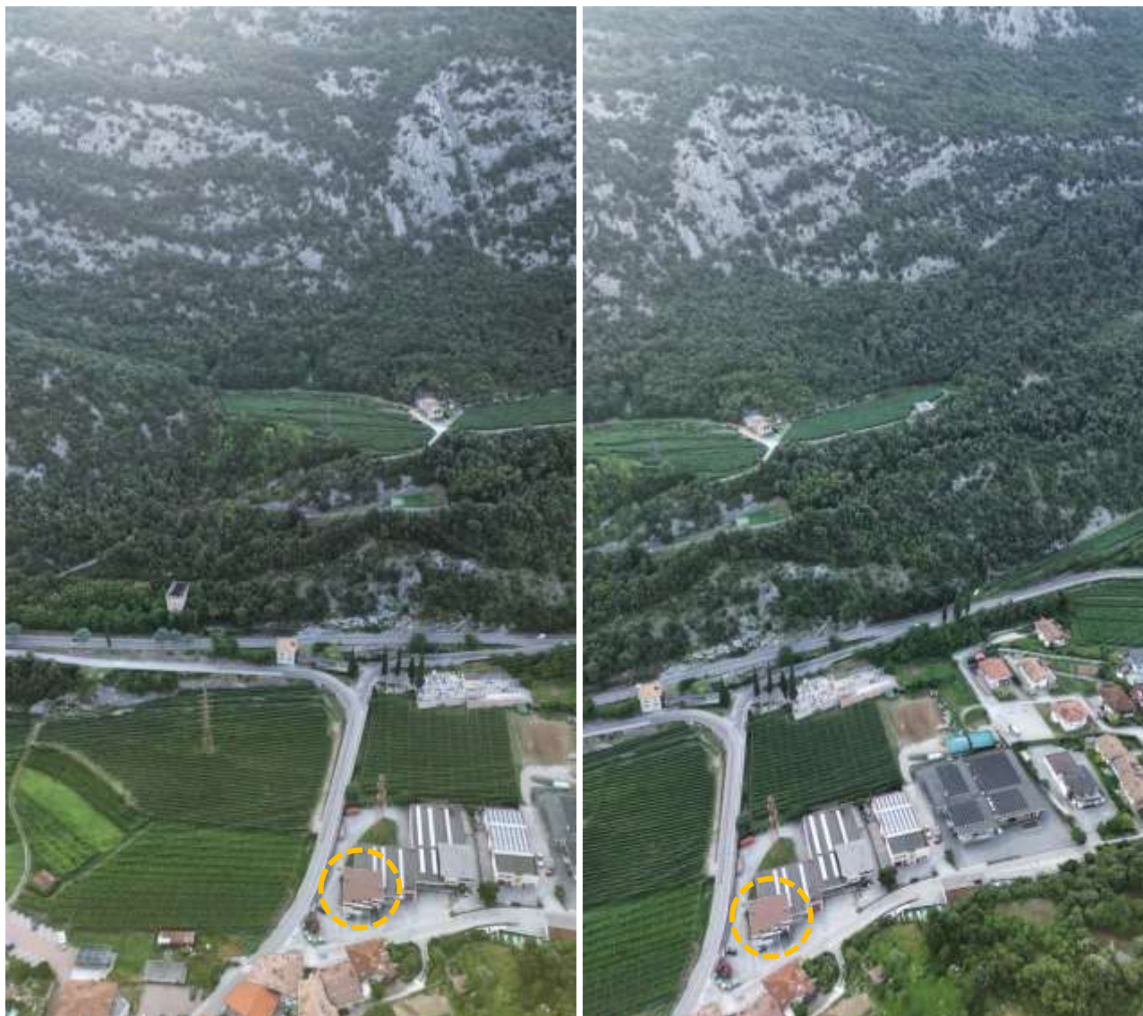
Figura 7.1 Vista da Ovest
