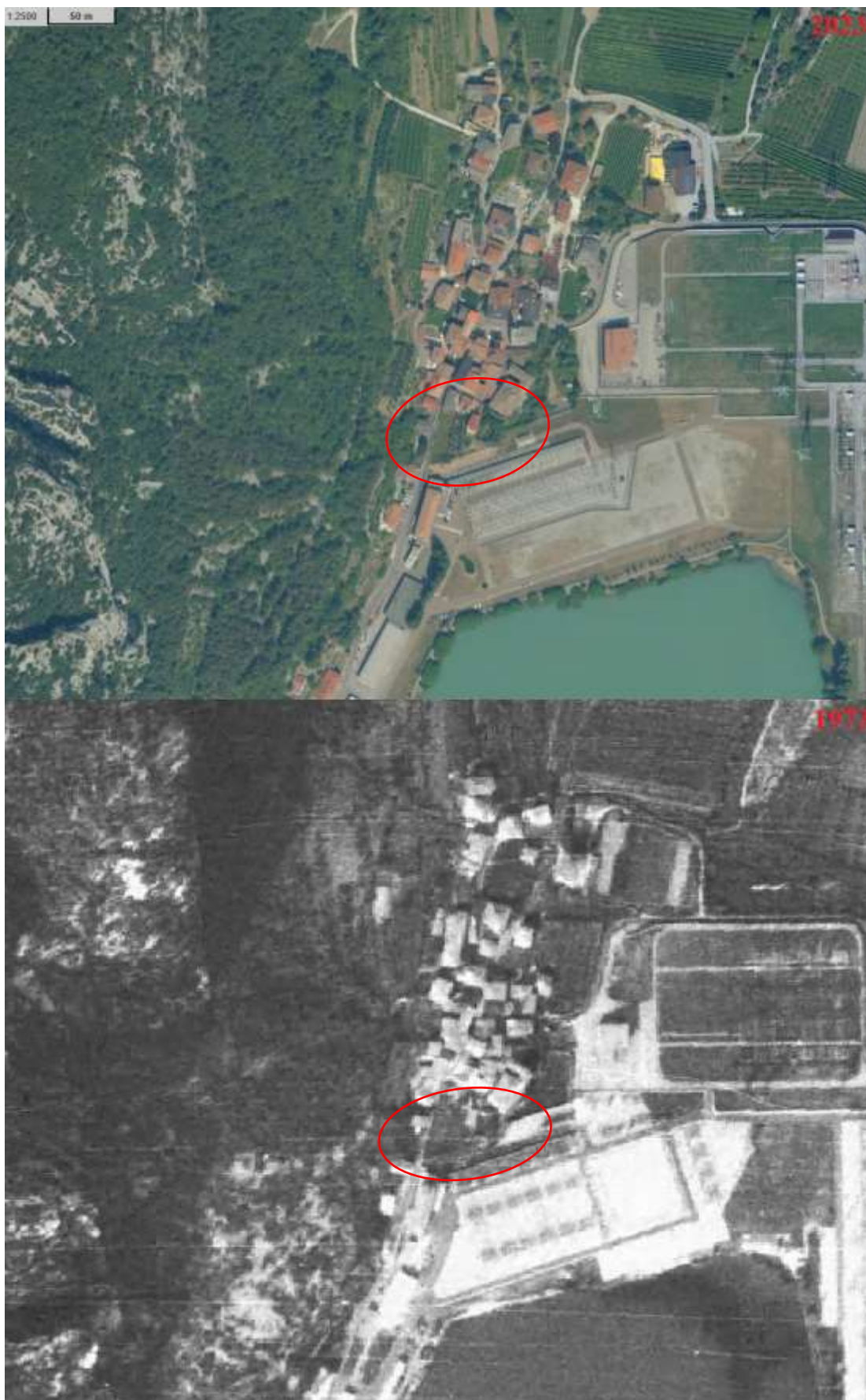
Figura 3.10: Ortofoto del 1973 e del 2023 dell'area.
