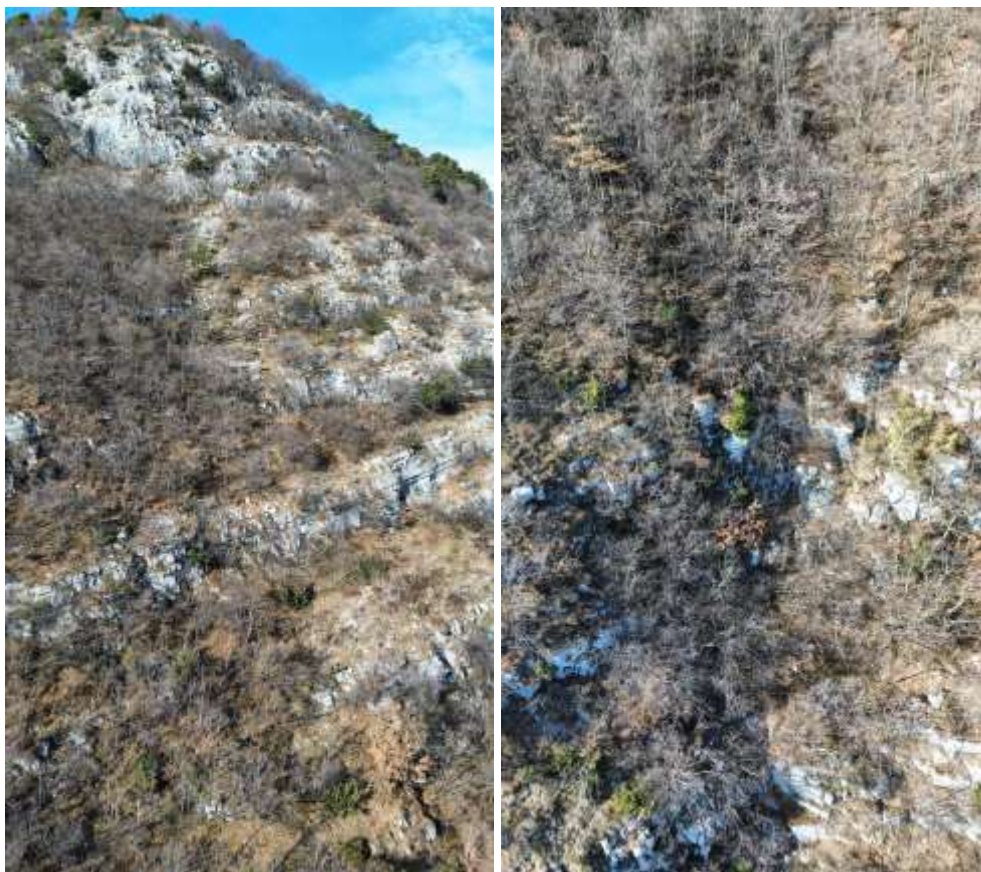
Figura 6.5 Foto dall'alto sulle pareti di interesse. Da notare la presenza diffusa di blocchi dislocati
