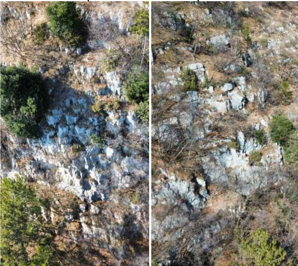
Figura 6.4: Foto dall'alto sulle pareti di interesse. Da notare la presenza diffusa di blocchi dislocati
