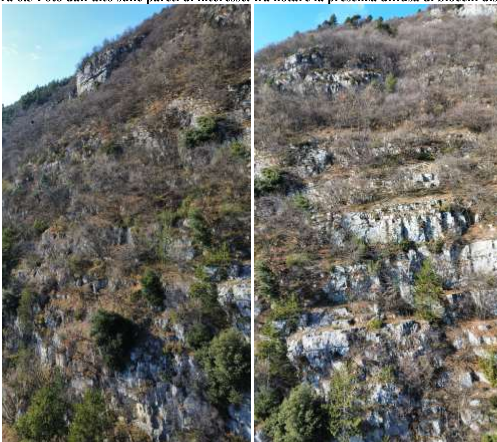
Figura 6.6 Foto dall'alto sulle pareti di interesse. Da notare la presenza diffusa di blocchi dislocati
