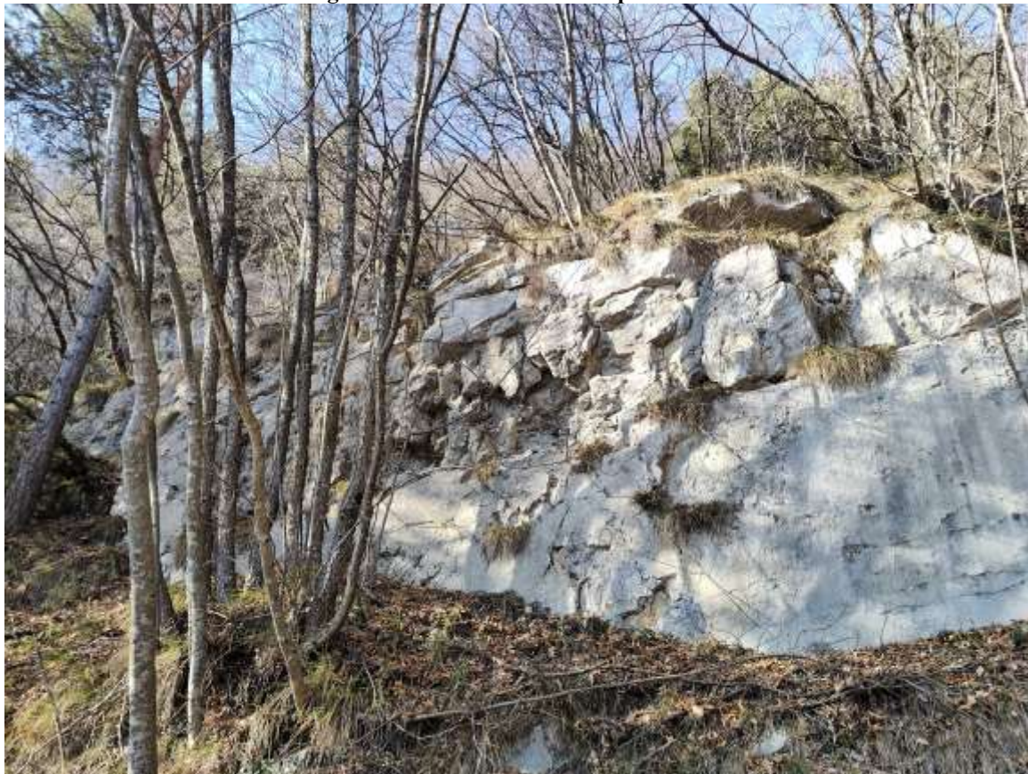
Figura 6.10 Esempio di variazione importante nella caratteristiche dell'ammasso roccioso (situazione diffusa).
