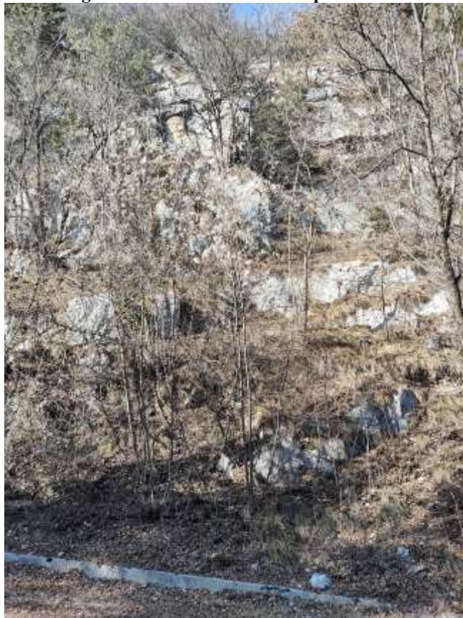
Figura 6.8 Pareti ai margine della viabilità per Nembia
