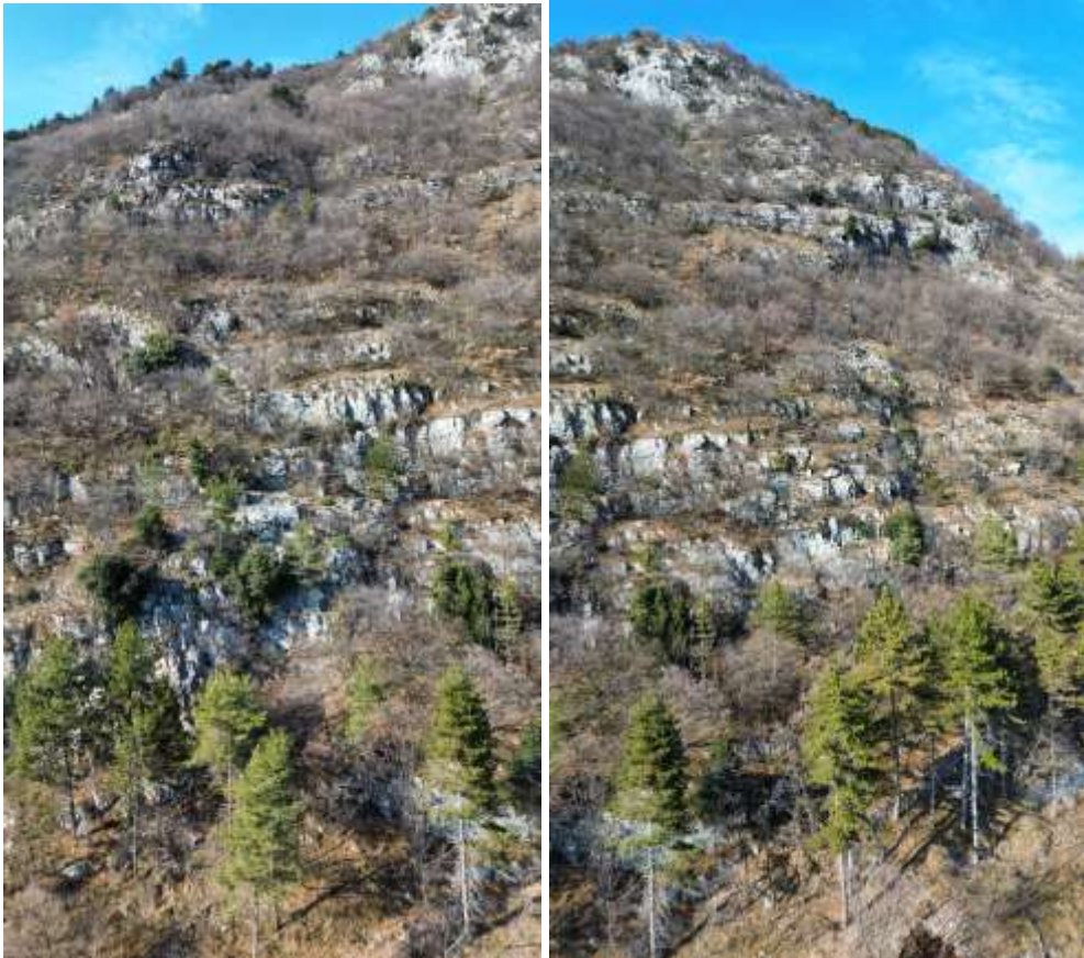
Figura 6.3: Foto dall'alto sulle pareti di interesse. Da notare la presenza diffusa di blocchi dislocati
