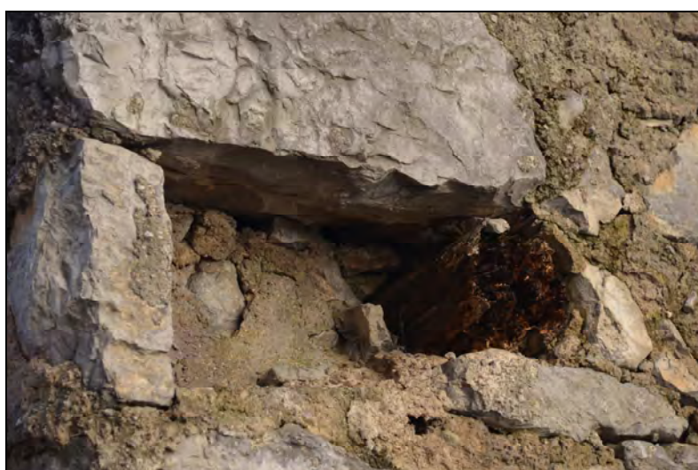
Scorcio interno e particolare muratura con innesto travi
